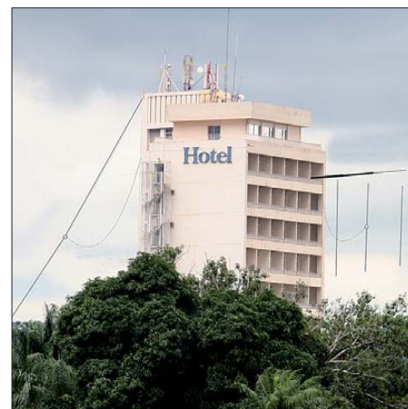
Das Hotel in Bangui mit dem Sloper (links) und dem Drahtbeam (rechts, schematisch dargestellt); mehr zum Drahtbeam in FA 4/2011, S. 414–415
