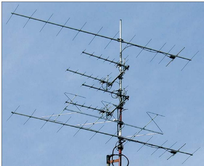
Bild 5: Ansicht der gesamten Antennenanlage für 2 m und 70 cm mit einem Triple-M-Beam für 6 m unterhalb der 70-cm-Antennen
